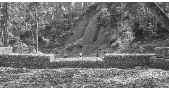
(上左) 河道の拡幅後、インフラ設置の一環としてじゃかごづくりの作業に参加する住民たち (上右) 洪水によって根元からなぎ倒された木 (下左) 防砂ダムは水とともに流れる土砂等をせき止める役割を担う (下中央) 災害管理委員会の定例会議の様子 (下右) 非常持ち出し袋の中身を見せてくれる住民(左)とその話を聞く職員
